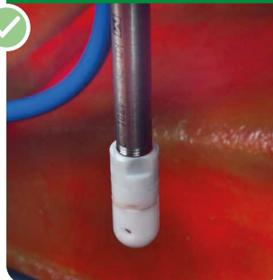
Nettoyage de la cuve
